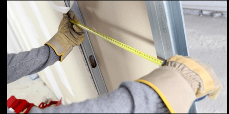
Выезд и замер при необходимости
